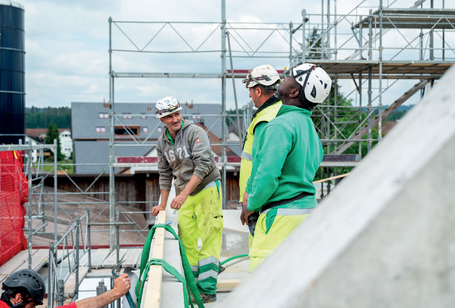
Das Team um Polier Bruno Brunner im Abschluss des Rohbaus.
