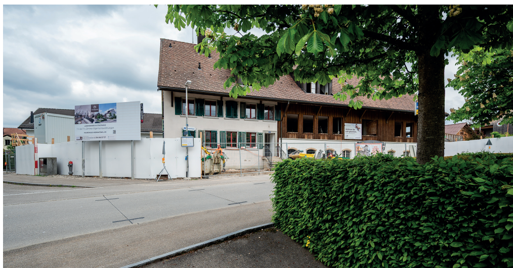
Der zweiteilige Landgasthof wird für einen neuen Lebensabschnitt umgebaut.
