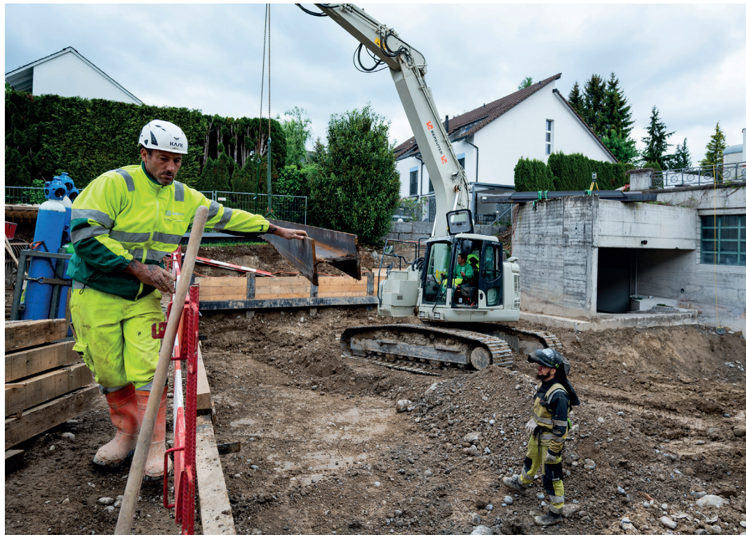
... wenig später positioniert das Team den Träger auf den angeschweissten Auflagern.
